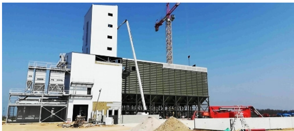
Рис. 1.2. Будівництво силосного корпусу із квадратними металевими силосами компанії Ceres Groupe [99]
